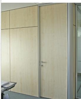
La utilización de tableros de 19 mm combinados con cristales acústicos y juntas de estanqueidad, confieren al conjunto un excelente comportamiento al ruido.
